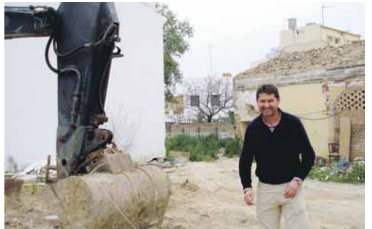
VIVIENDAS SOCIALES. Curro Godoy visitó las obras recién iniciadas.
