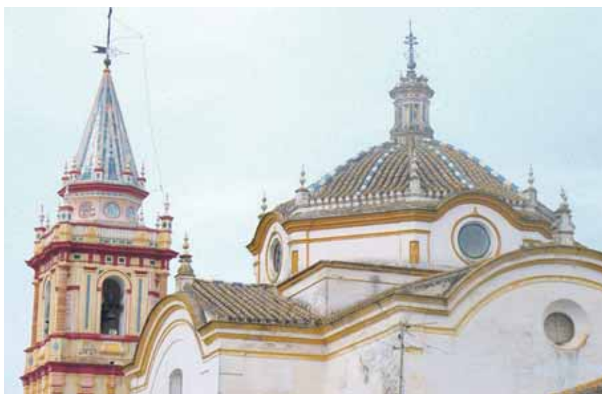
SAN MARTÍN DE TOURS. La parroquia es un templo construido en el siglo XVIII.
