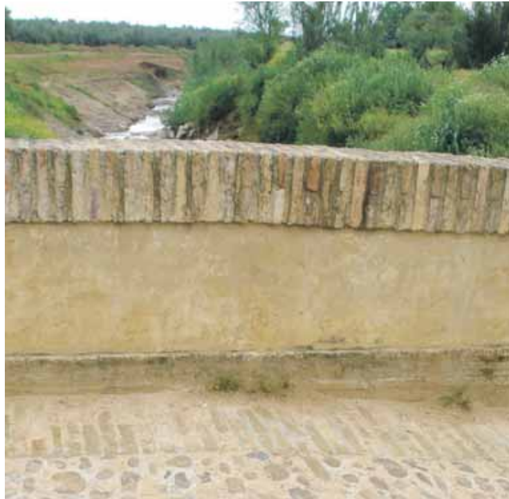
UBICACIÓN. La subestación se construirá próximo a este puente.
