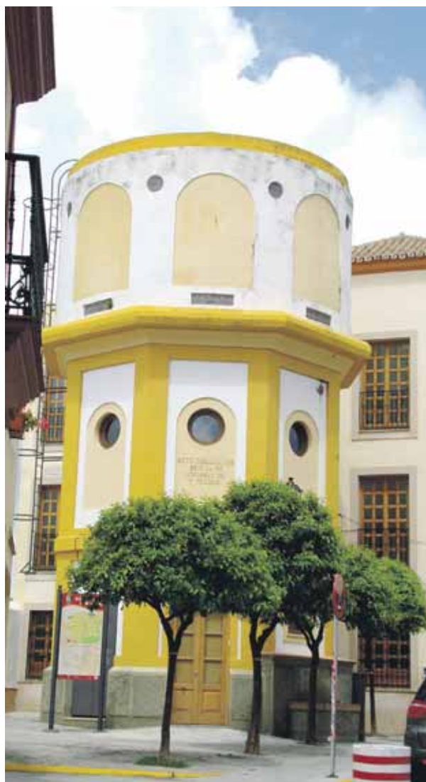
EDIFICIO. El antiguo depósito del agua es la sede de la Oficina Turística.
