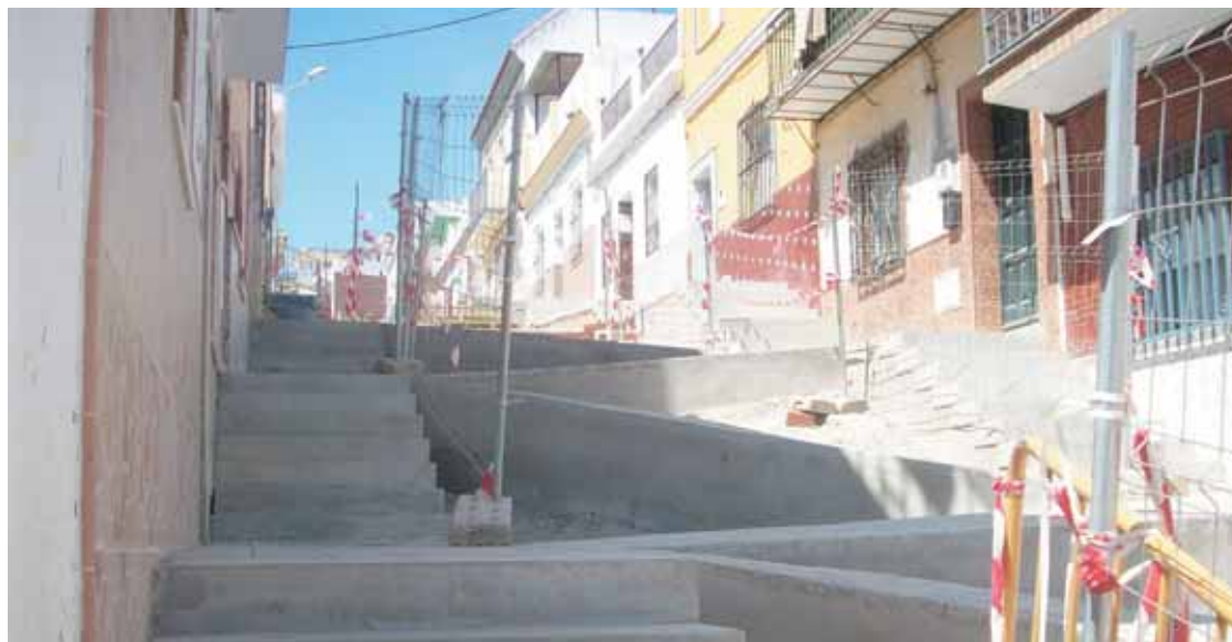
Aspecto actual que presentan las obras de La Extremeña, concretamente la calle Gerona.
