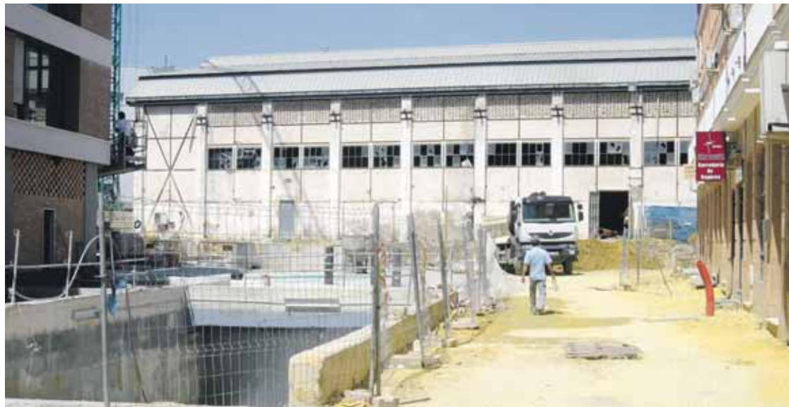
Aspecto actual que presentan las obras en la zona con la nave Fembase al fondo.
