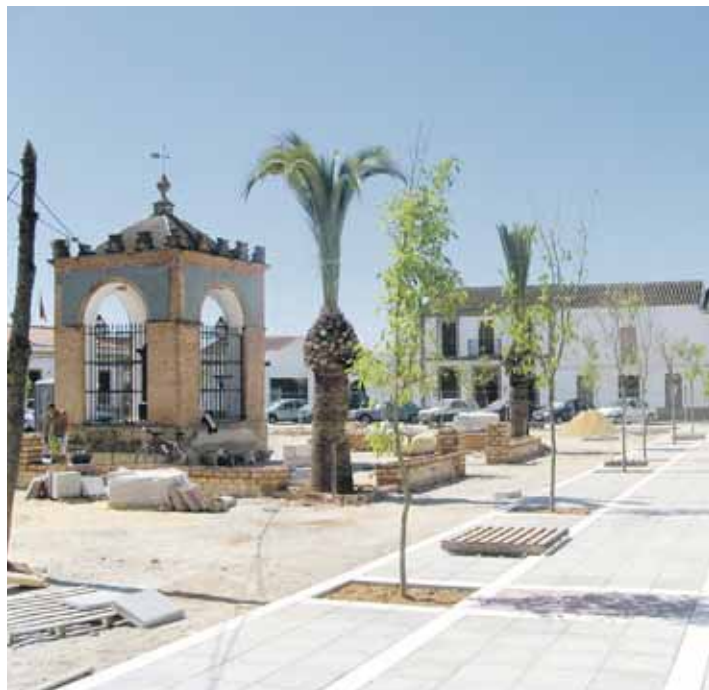
OBRAS. Estado actual que presenta la Plaza de España.
