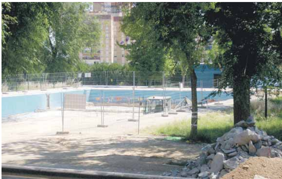
Palés, maquinaria y escombros llenan las instalaciones de la piscina municipal.
