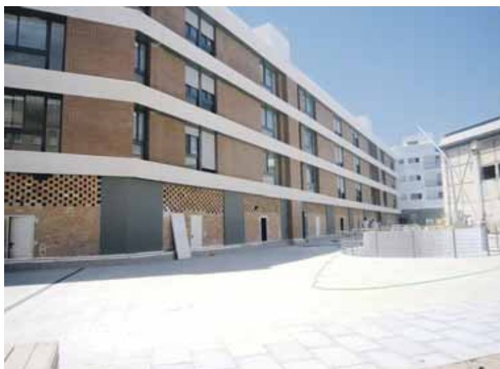
Aspecto actual que presenta las viviendas sociales de Nave Fembasa.
